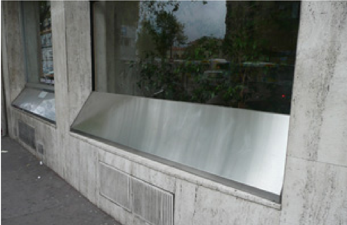
(Abbildung 5: Ein schräges Edelstahlblech verhindert das Liegen und Sitzen in einem Schau- fenster ©Arnaud Elfort, Guillaume Schaller – survivalgroup.org)
