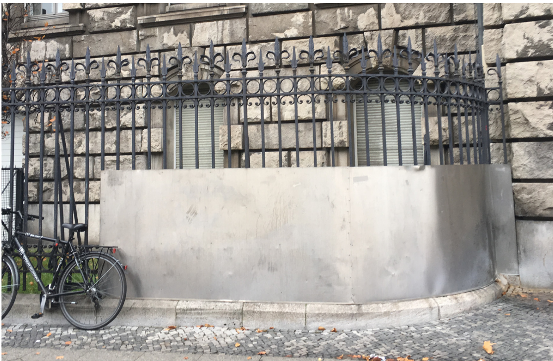
(Abbildung 20: Edelstahlbleche in Berlin lassen Urinstrahlen abprallen und verhindern zugleich das Anschließen von Fahrrädern am dahinterliegenden Zaun. ©Martin Binder)
