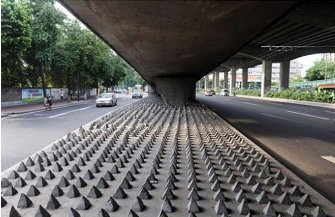
(Abbildung 19: Unter dieser Brücke in China verhindern Metallpyramiden längere Aufenthalte. ©Andrew Horton/ Ethical Pioneer/ Twitter)
